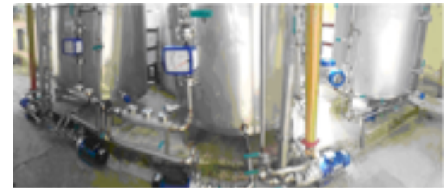
Impianto pilota (fase C)
